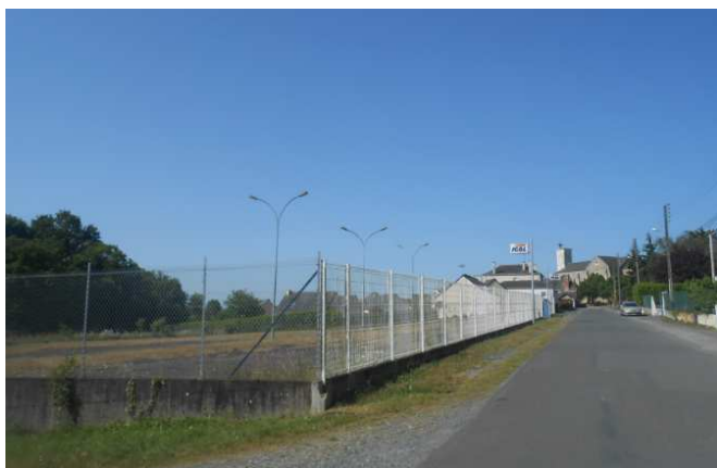
Emprise du parking d'une ancienne activité de garage automobile (rue du gué)
