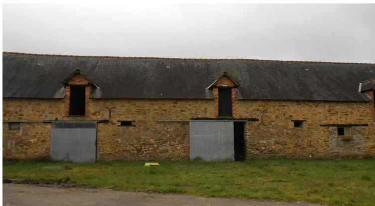
La Cour Péan (sur site agricole)
