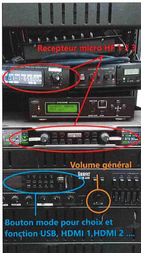
Photo commande branchement vidéoprojecteur
