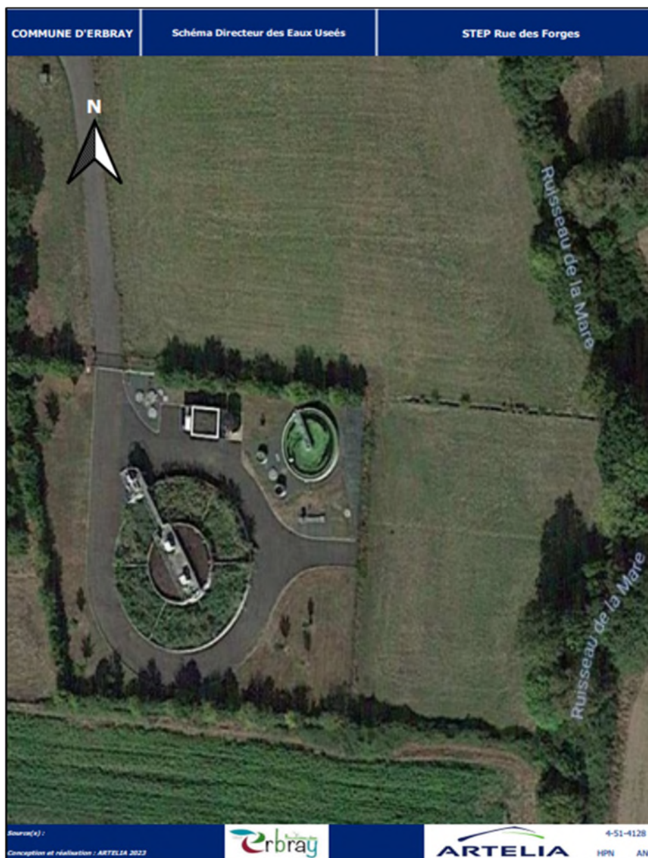
Figure 12:présentation des ouvrages présents sur la station d'épuration
